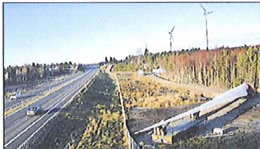
PÅVENT En trailer med vingeseksjon venter på tur for å slippe inn til vindmøllen som settes opp bakerst i bildet. Området ligger tett til E6, sør for Skee i Sverige.
